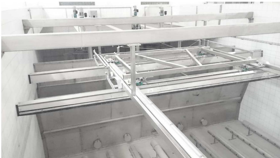
Obr. 3. Vestavba technologie flotace v původních filtrech
